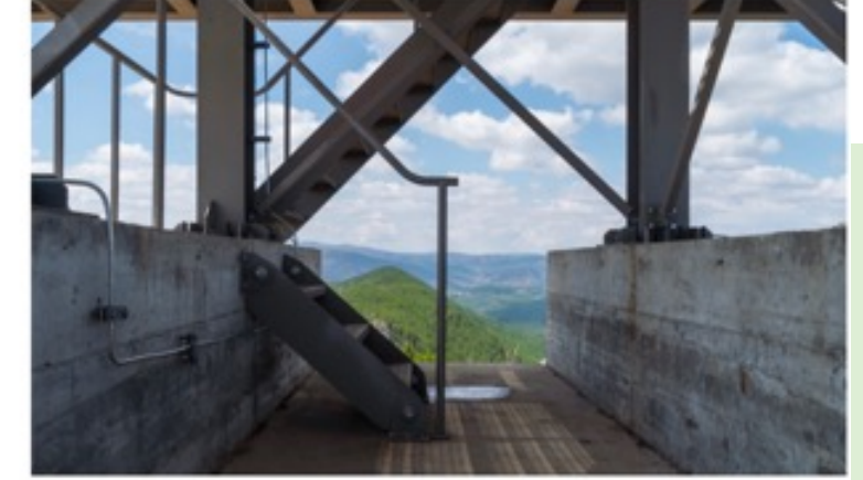
Figura 7.28. Detalle de la plataforma.
