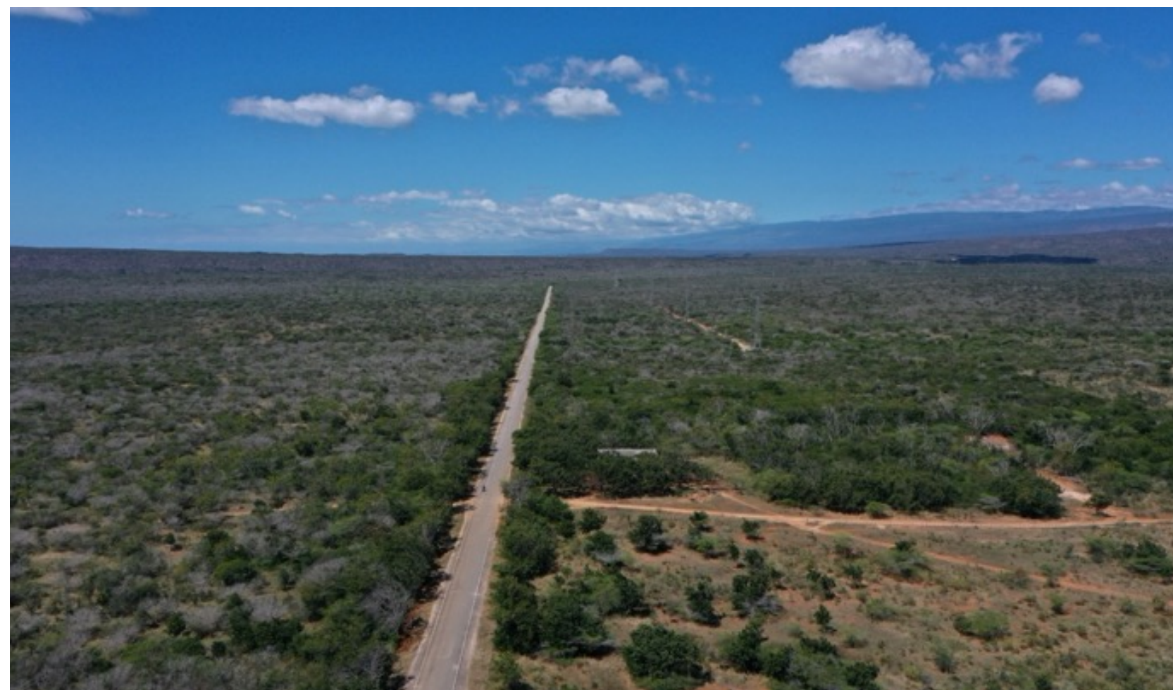
Figura 6.62. Vía actual hacia Pedernales.
