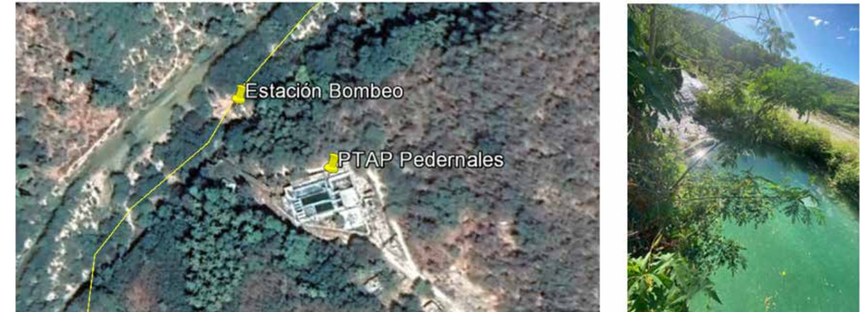
Figura 6.4. Planta de tratamiento acueducto de Pedernales
