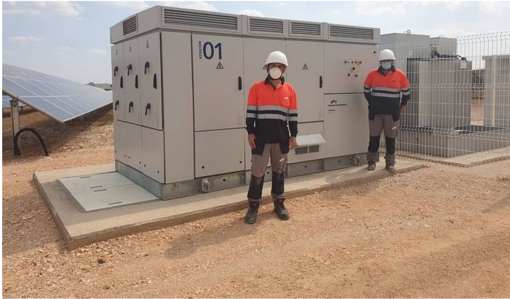
Figura 6.30. Sistema de almacenamiento de energía cargada por medio de un sistema de almacenamiento de energía eléctrica por medio de baterías
