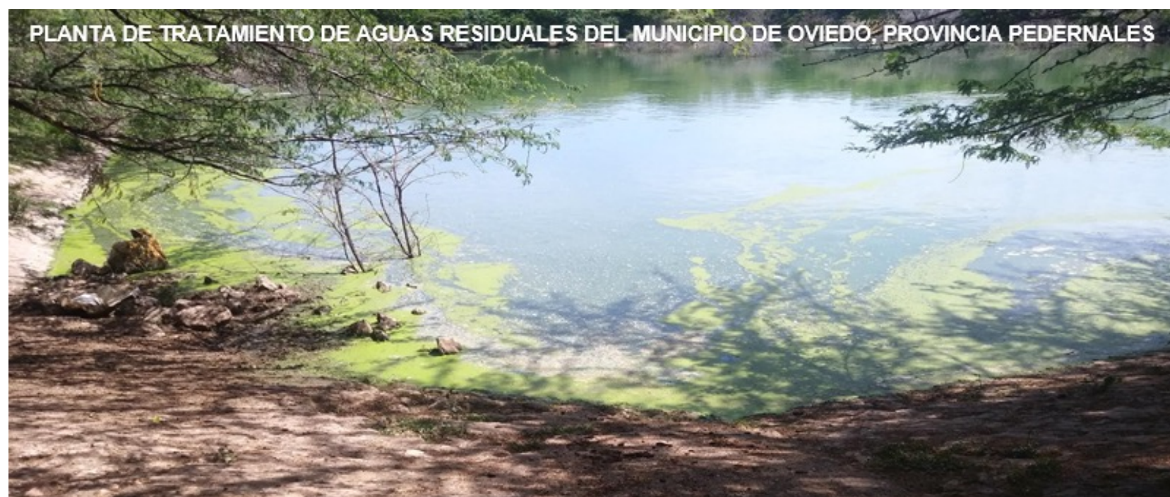
Figura 6.1. Planta de tratamiento de aguas residuales.
