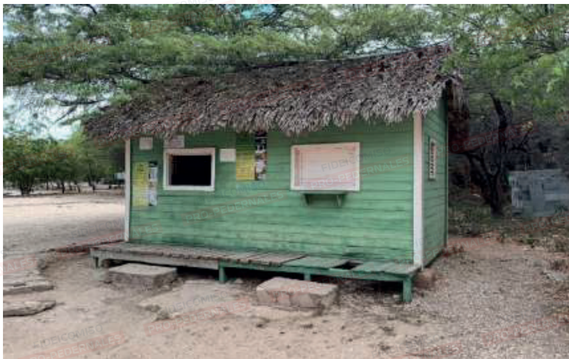
Figura 22 Caseta de boletería.
