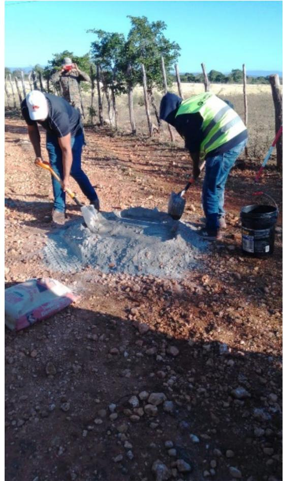
Ilustración 4 - Mezcla Hormigón
