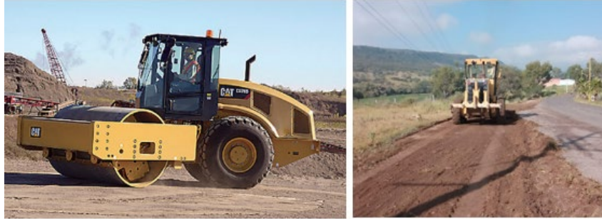
Compactado y regado de material de relleno”
