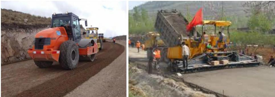
**Colocación de Base por medio de pavimentadora y motoniveladora**
